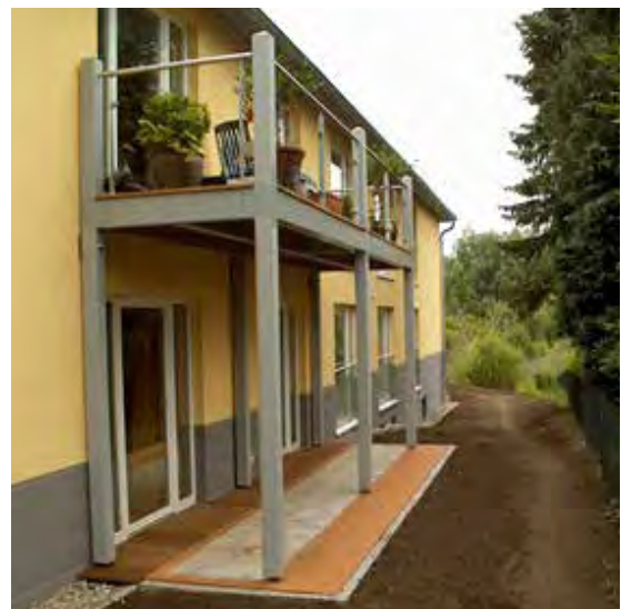
Balkonanlage mit offenem Belag in Nutzungsklasse 3
