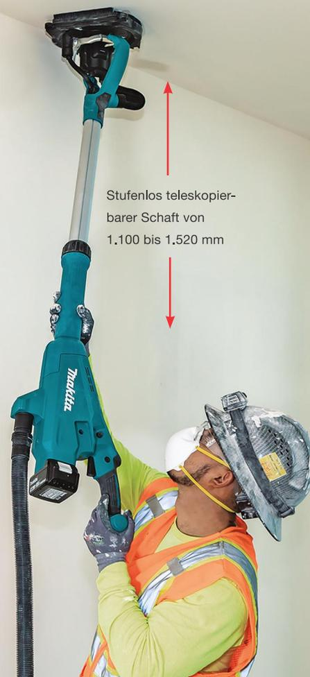
Stufenlos teleskopierbarer Schaft von 1.100 bis 1.520 mm
